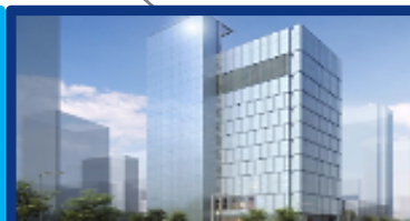
大阪第5 データセンター 2016年1月
