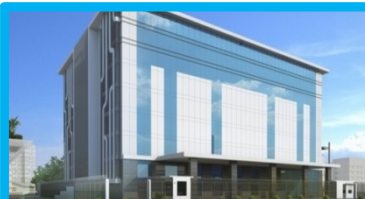
インド ムンバイ 5 データセンター 2015年10月
