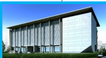
タイ バンコク 2 データセンター 2015年12月
